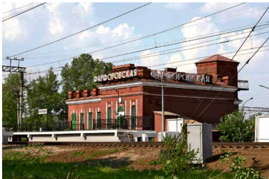
Вокзал станции Фарфоровский пост постройки начала XX в.
