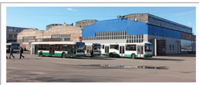
Филиал на Бухарестской улице, ремонтные боксы, 2016 г.
