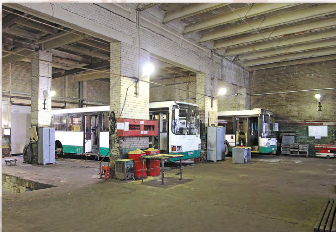
Бокс ремонта ТО-2 на территории филиала
