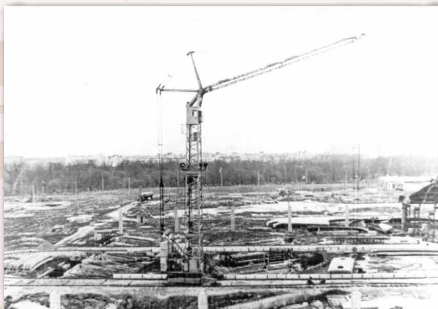
Строительство автобусного парка (хранение фото — Автобусный парк № 5)
