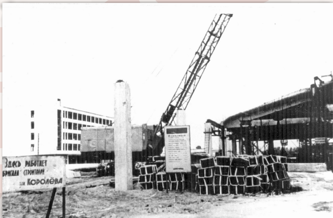
Строительство автобусного парка (хранение фото — Автобусный парк № 5)
