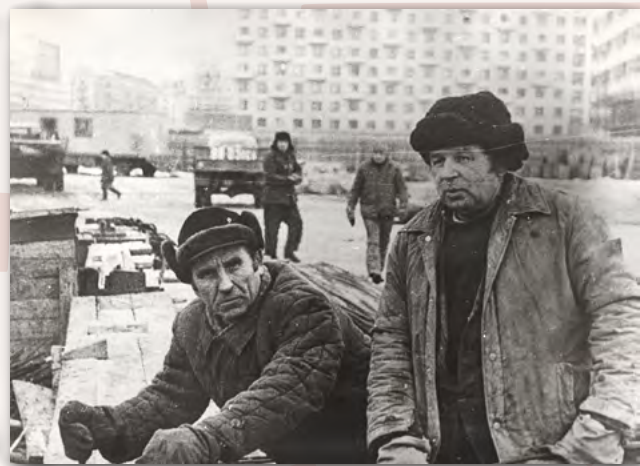
Яков Нилович Захарцев (слева) на строительстве монумента (хранение фото — Автобусный парк № 5)
