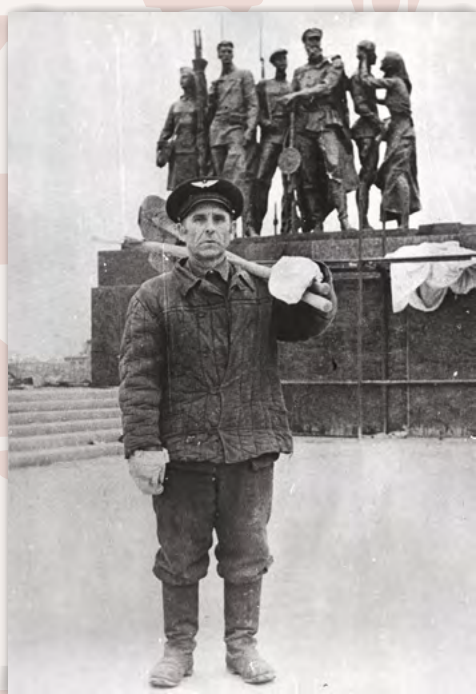
Яков Нилович Захарцев на строительстве монумента (хранение фото — Автобусный парк № 5)
