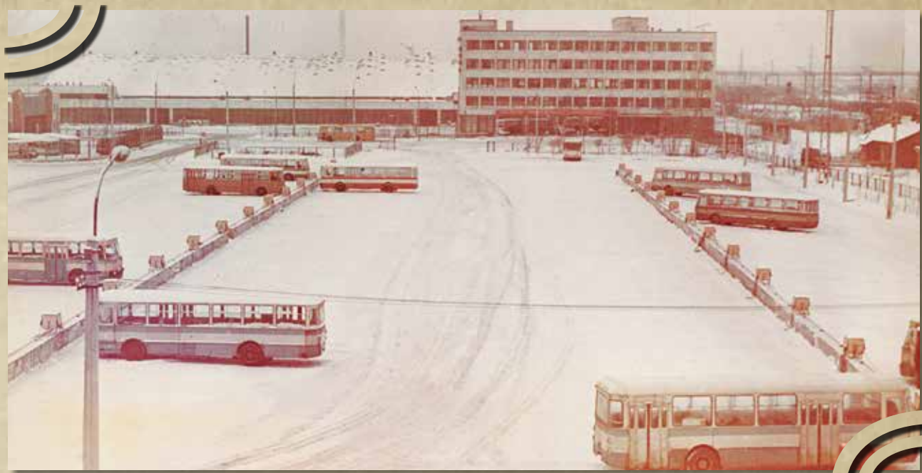
Площадка отстоя парка с газовой системой подогрева автобусов, 1970-е гг. (хранение – Автобусный парк № 6)
