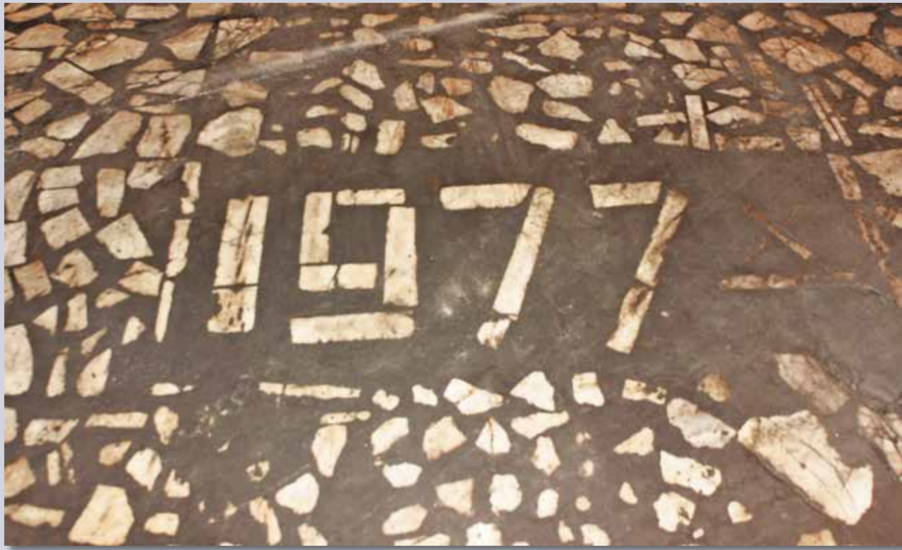
Отметка строителей нового покрытия пола
