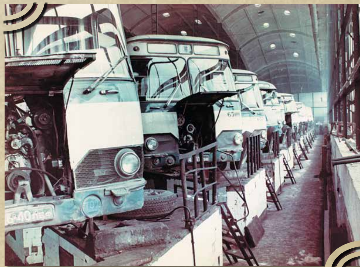
Техническое обслуживание автобусов (ТО-2), 1970-е гг. (хранение – Автобусный парк № 6)
