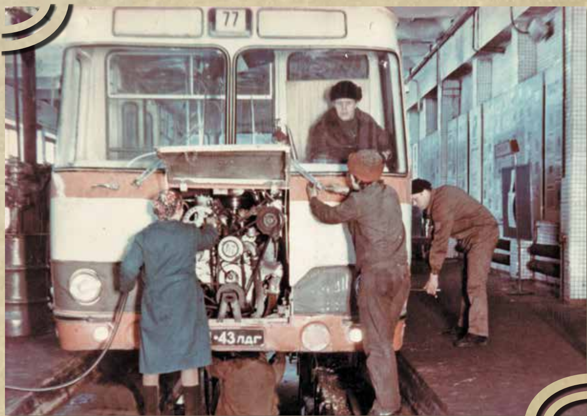
Техническое обслуживание автобуса (ТО-1), 1970-е гг. (хранение – Автобусный парк № 6)
